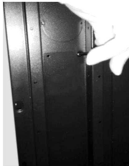
Таким же образом закройте отверстия кабельных вводов в нижней панели.
