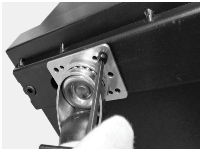
При помощи 16 самонарезающих винтов ST5,5x10 с головкой с внутренней шестиконечной звездой закрепите 4 высокопрочных 2” ролика к нижней панели шкафа. Для затяжки соединений используйте входящий в комплект шестигранный ключ.
