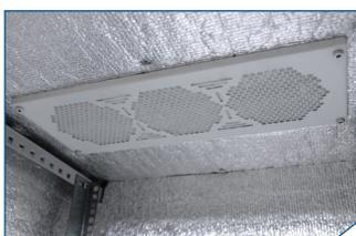
Фильтр предназначен для установки в основание или крышу напольных и настенных монтажных шкафов. Препятствует проникновению пыли внутрь монтажных шкафов. Для установки демонтируется заглушка, и фильтр фиксируется четырьмя винтами.
