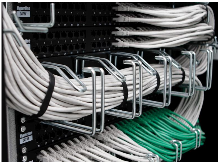
Пример установки горизонтальных организаторов.
